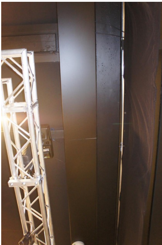
Truss 3 och Nersänkt byggnadskonstruktion i taket. Salen lägsta fria höjd som även begränsar trussarnas löpande djup.
