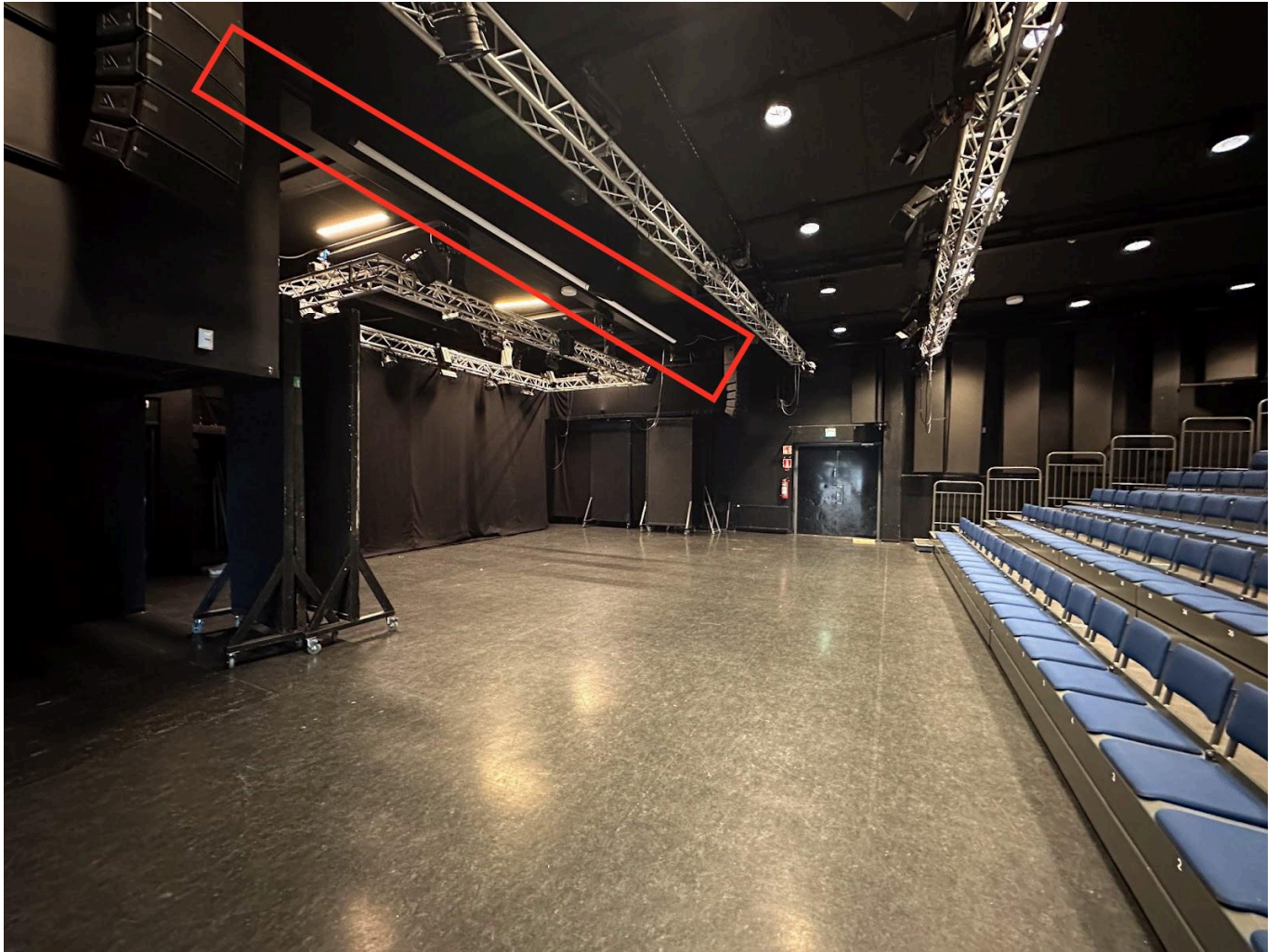
Truss 3 och den nedsänkta byggnadskonstruktionen i taket. Denna konstruktion representerar salens lägsta fria höjd och begränsar även trussarnas möjliga djup.
